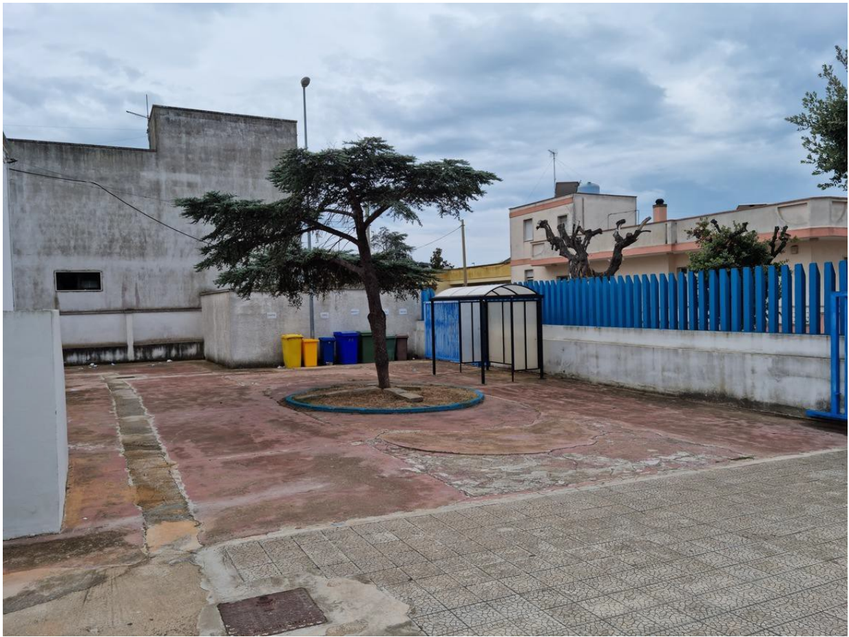
Fig 3. Scuola secondaria di primo grado – Racale Via Piemonte
