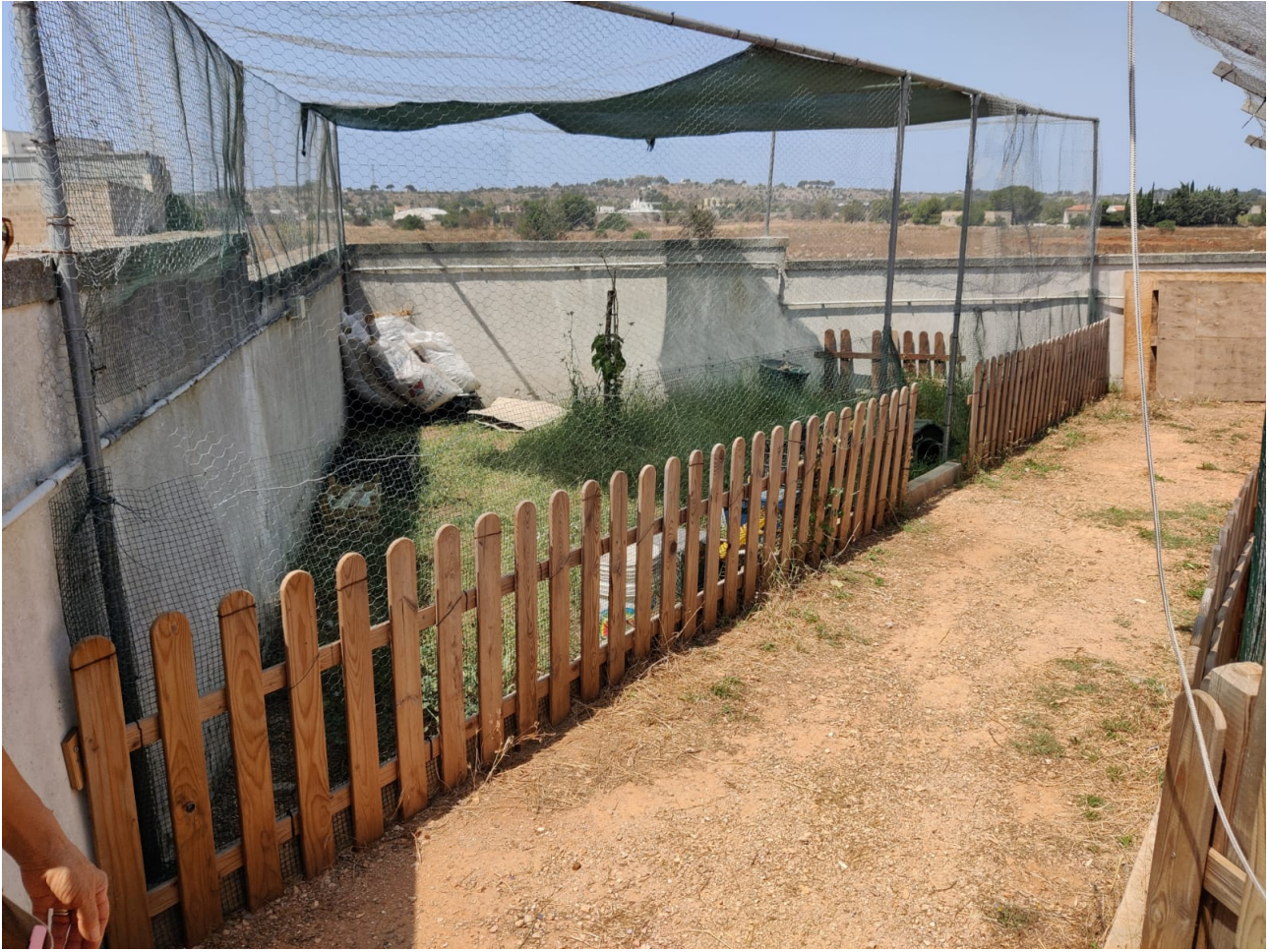
Figura 3 - Staccionata e recinzione metallica perimetrale e di copertura per recinto a confine
