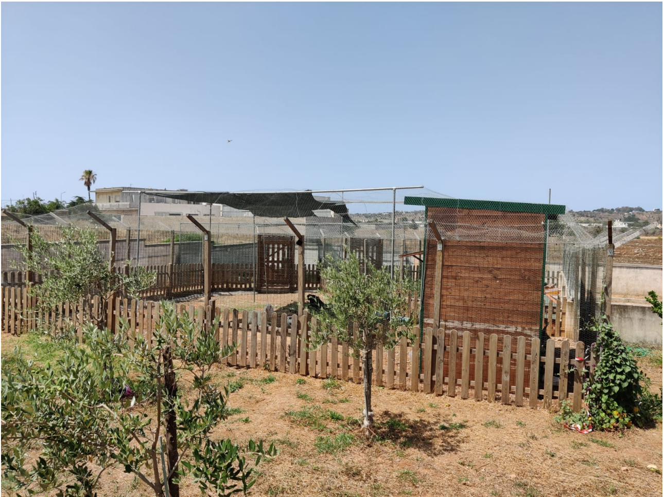
Figura 2 - Recinto per animali protetto con rete metallica
